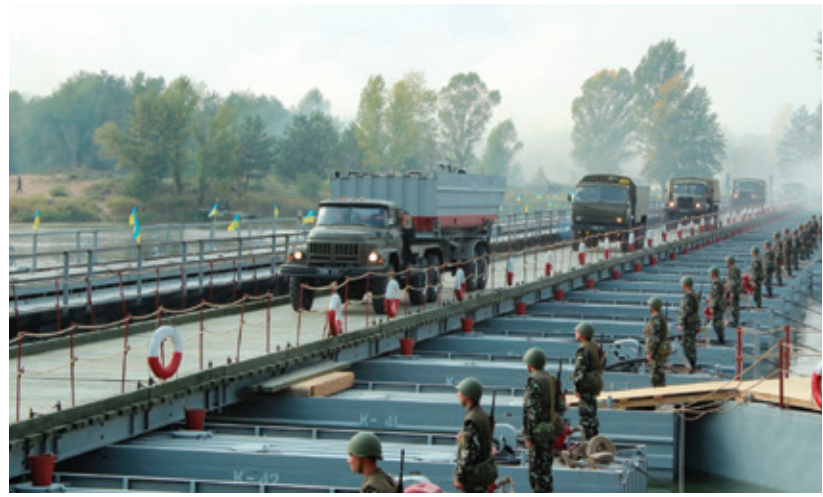
Випробування наплавного моста рухомим складом
