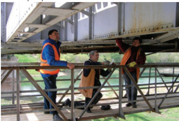
Обстеження прогонової будови співробітниками лабораторії
