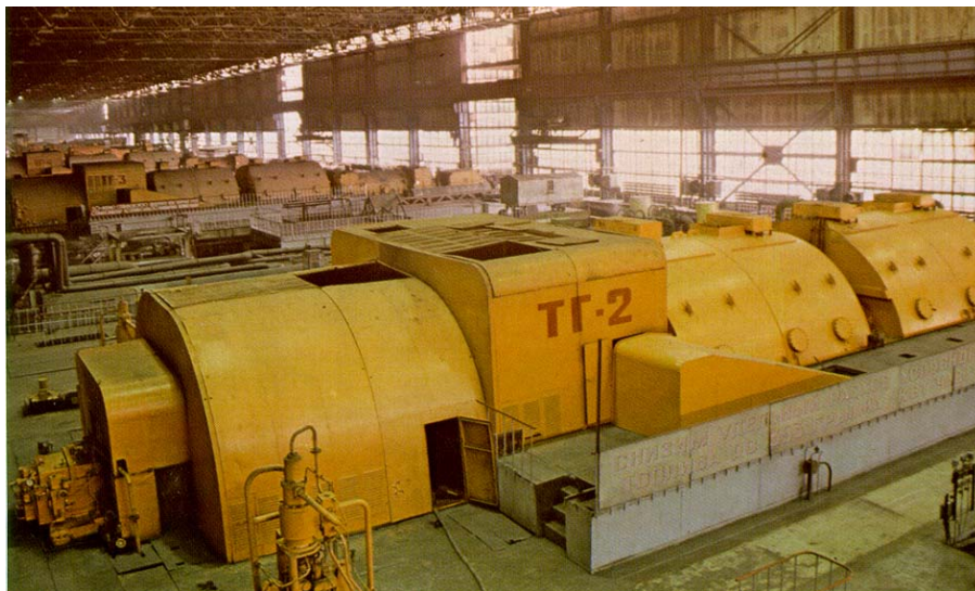
Рис. 1. Паровая турбина на сверх критические параметры пара типа К-500-240
