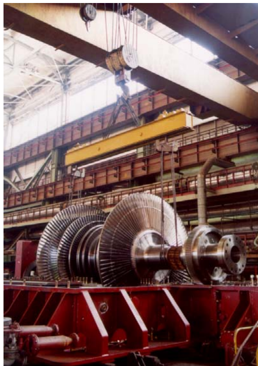
Рис. 4. Сборка цилиндра низкого давления паровой турбины
