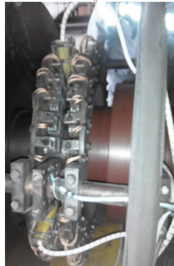
Рис. 7 – Установка первинних перетворювачів на щітково-контактному апараті
