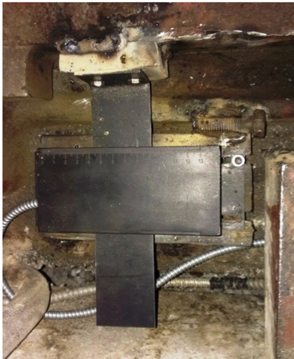
Рис. 10 – Установка первинного перетворювача для контролю розширення ЦВТ
