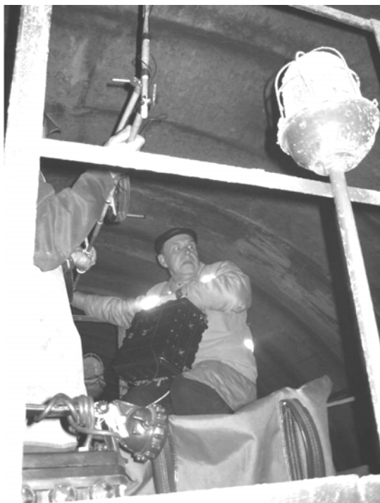
Рис. 3. Исследование состояния конструкции с помощью георадара
