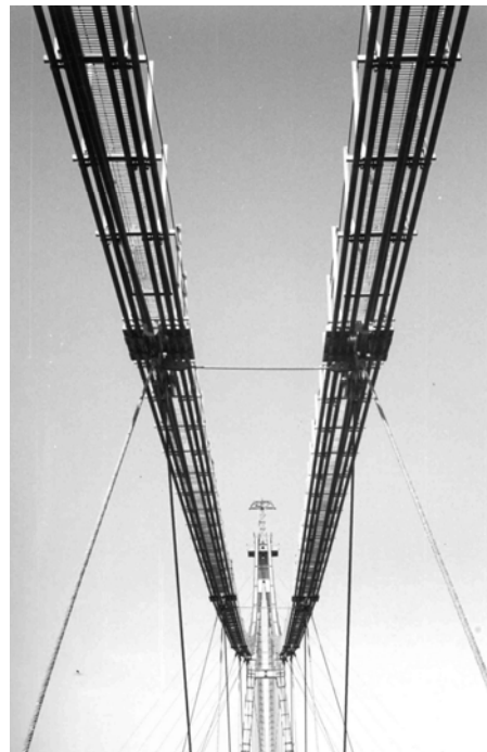
Рис. 5. Пилон. Кабели и наклонные подвески висячих ферм
