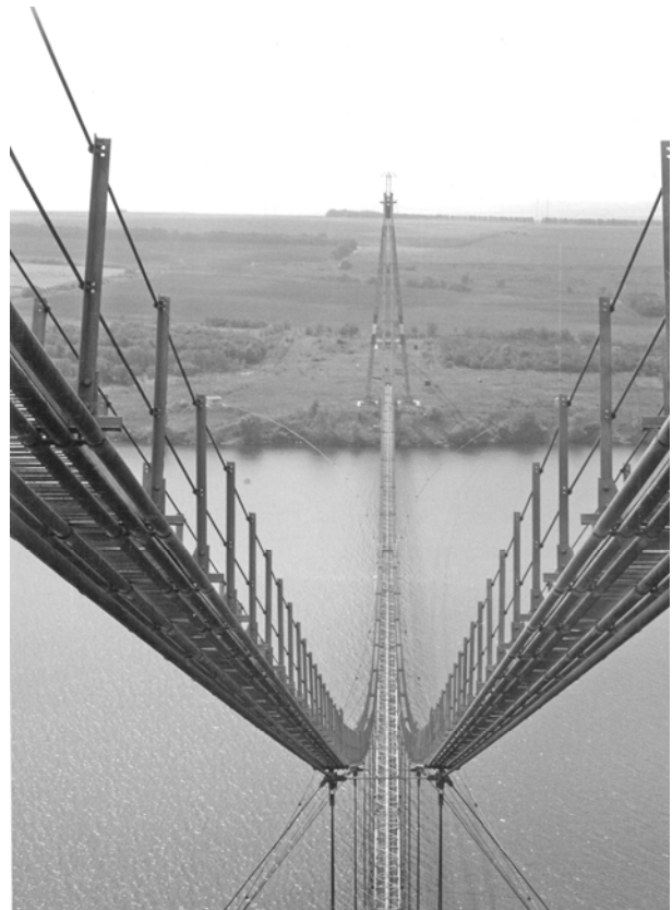
Рис. 2. Общий вид моста с пилона правого берега
