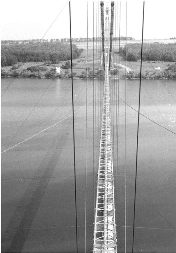
Рис. 6. Наклонные подвески и балка жесткости
