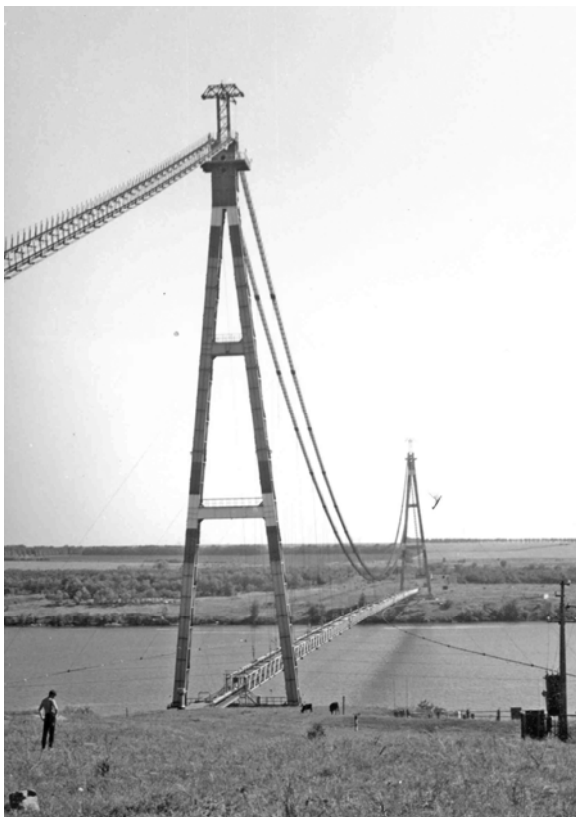
Рис. 1. Общий вид моста
