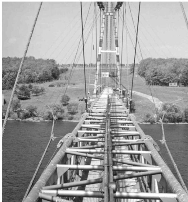
Рис. 4. Общий вид моста. Верхний пояс и наклонные подвески висячих ферм, балка жесткости, пилон, ветровая ферма
