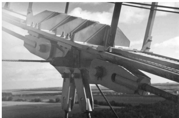
Рис. 9. Узел верхнего пояса висячей фермы
