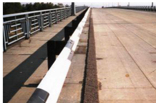
Рис. 5. Укладання дренажних брикетів
