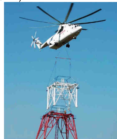
Рис. 4. Установка секції телевізійної вежі способом вільного монтажу
