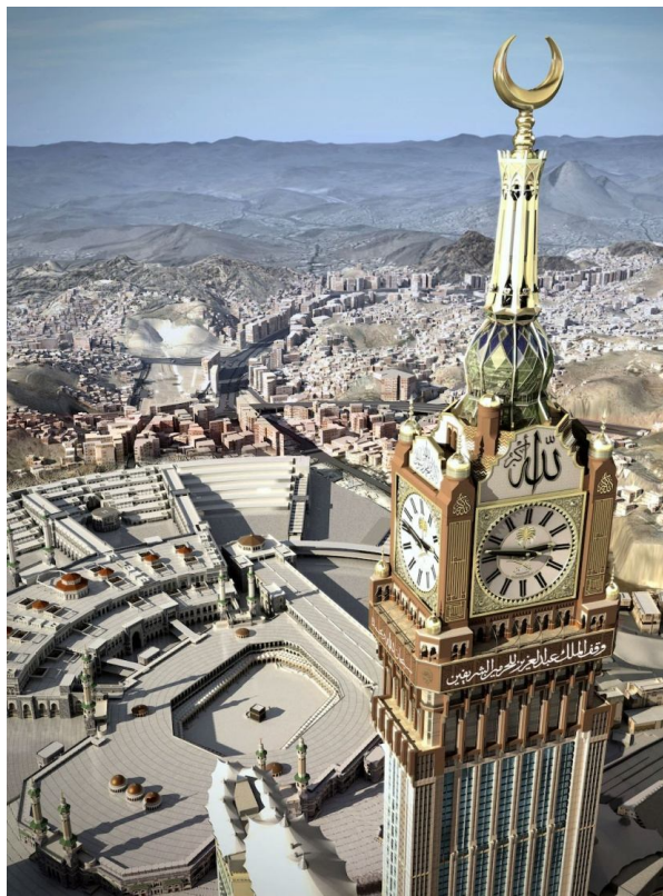
Рис. 1 – Башня Makkah Royal Clock Tower Hotel, изготовленная из листовой стали S355J2+N
