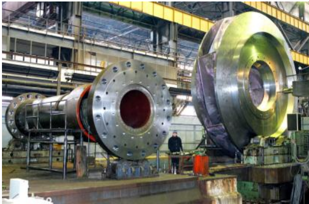
Рисунок 15 – Рабочий момент капитального ремонта и модернизации станка фирмы Шисс
