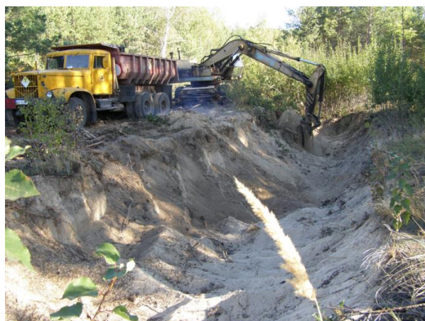
Рис. 2. Ліквідація траншеї з РАВ ПТЛРВ «Нова будбаза».
