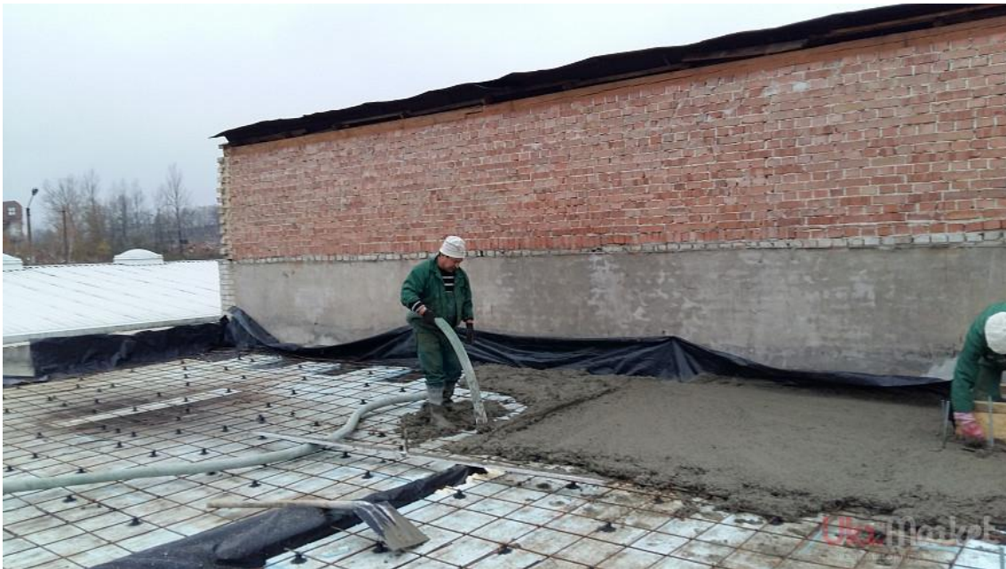
Рис 2. Загальний вид влаштування «вологоді» стяжки.
