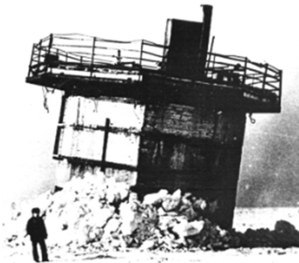
Рис. 2. Опорная конструкция строящейся платформы
